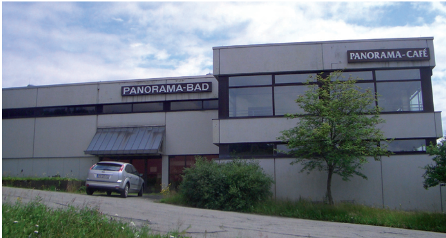
Hallenbad St. Andreasberg
